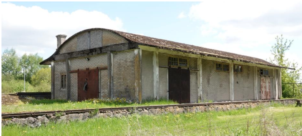
Joonis 11. Monoliitbetoonist silinderkatusega pagasi-kaubaait Rapla raudteejaamas. Foto: Cerly-Marko Järvela.
