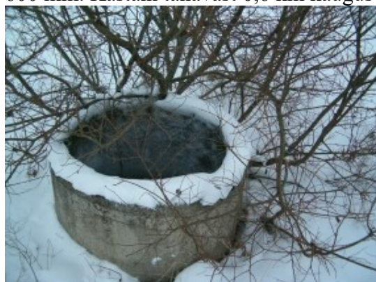
Joonis 3.4. Metsapargi ja Kastani tn sademeveesüsteemi kontrollkaev (vasakul) ja väljalask maanteekraavi Tuti ristmiku lähistel (paremal)
