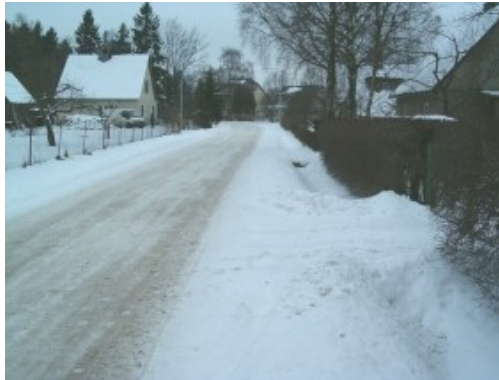
Joonis 3.2. Eha tänava sademevee- ja kuivenduskraav. Vasakul pool teed on kraav suletud torustikku.
