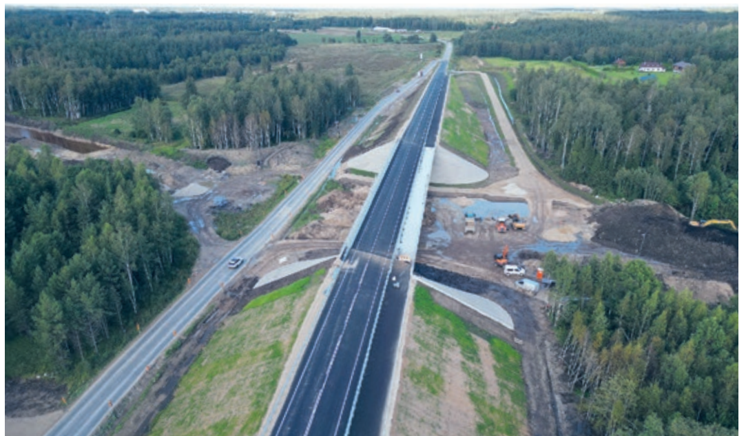
Rapla-Järvakandi-Kergu tee ja Rail Baltica raudteetrassi ristumiskohta rajatud Juula maanteeviadukt.
