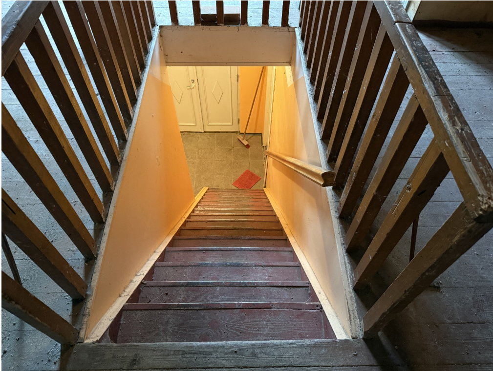
Foto 15 Trepp esikust (ruum nr 101) II korruse trepiahalli (ruum 201)
