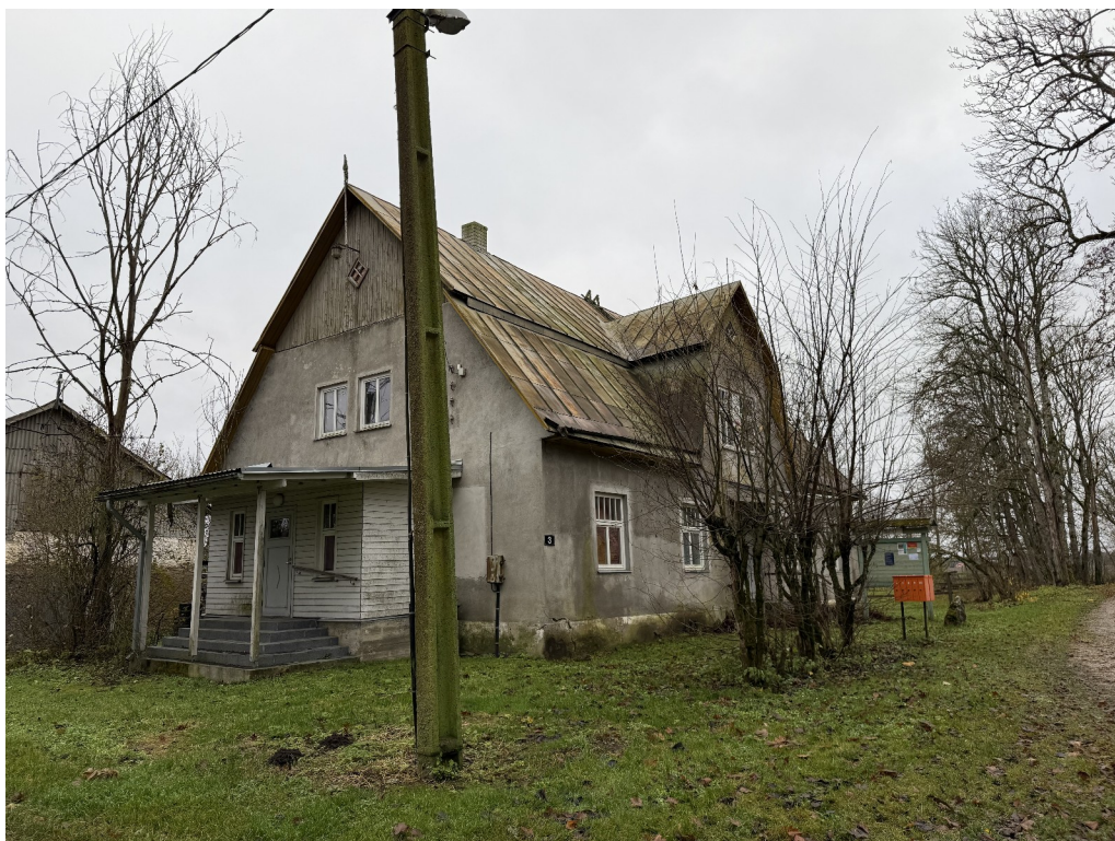
Foto 1 Vaade põhjast (hoone loode- ja kirdeküljele)
