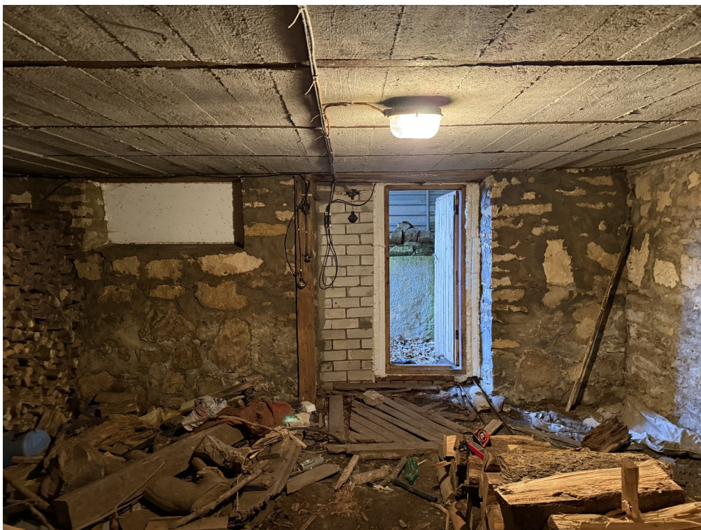
Foto 14 Hoiuruum keldrikorrusel (ruum nr 001)
