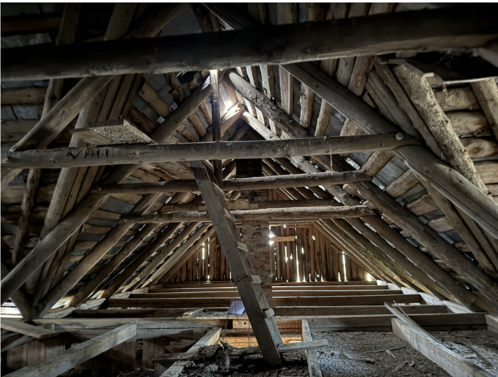
Foto 16 Pööningu vaade. Esiplaanil kohtkindel puitredel katuseluugini, redeli taga ava II korruse trepiahalli (ruum 201) ja pööningu vahel
