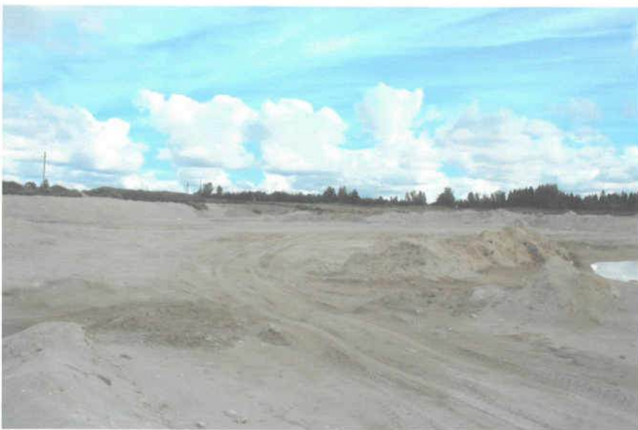
Foto 6 Vaade Laiamäe kinnistult Sopi kinnistu suunas (keskel Tõrva alajaam)
