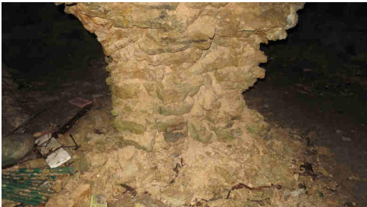
Foto 4. Keskne murenev piilar, lähivaade (Foto T.Villems)
