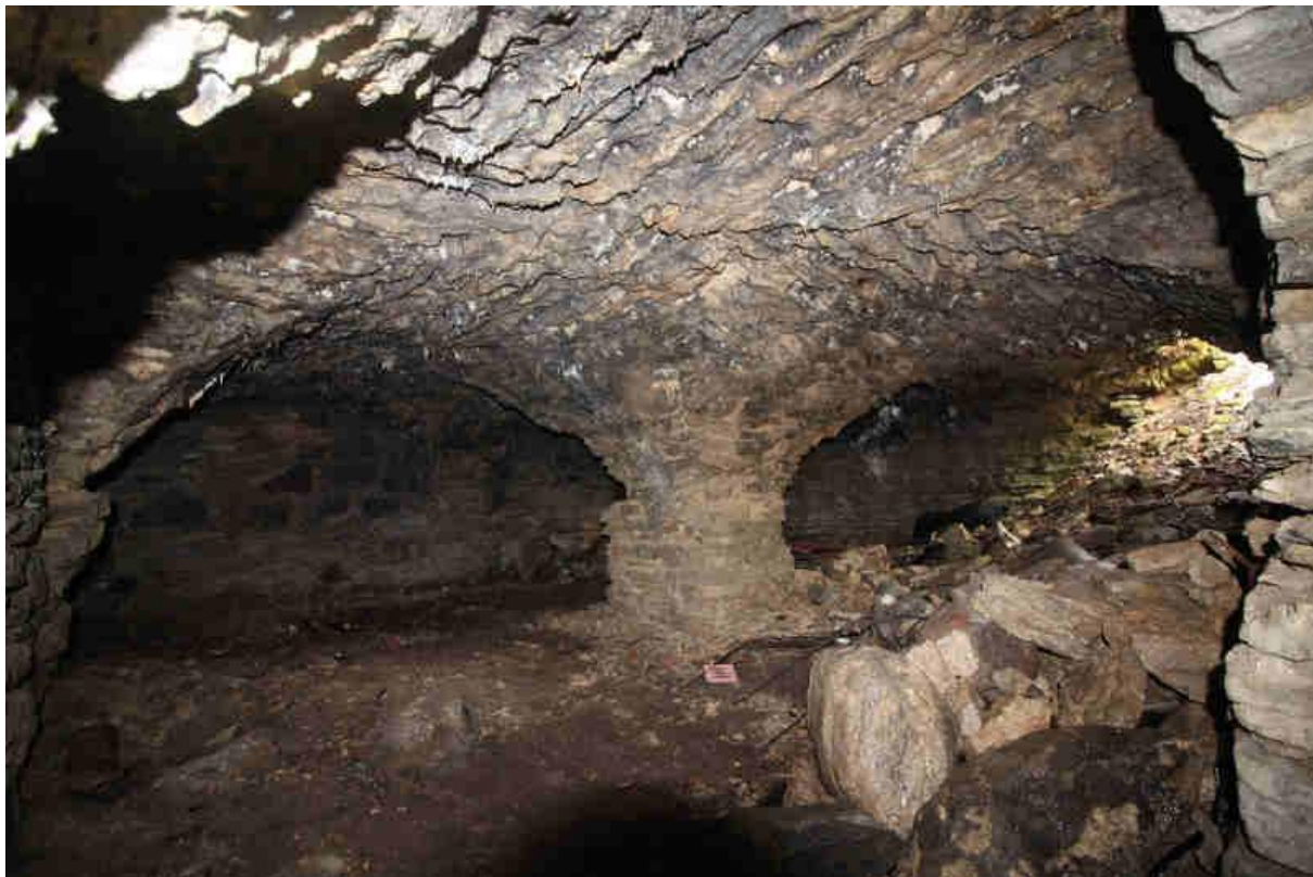
Foto 4. Keskne murenev piilar, lähivaade (Foto T.Villems)
