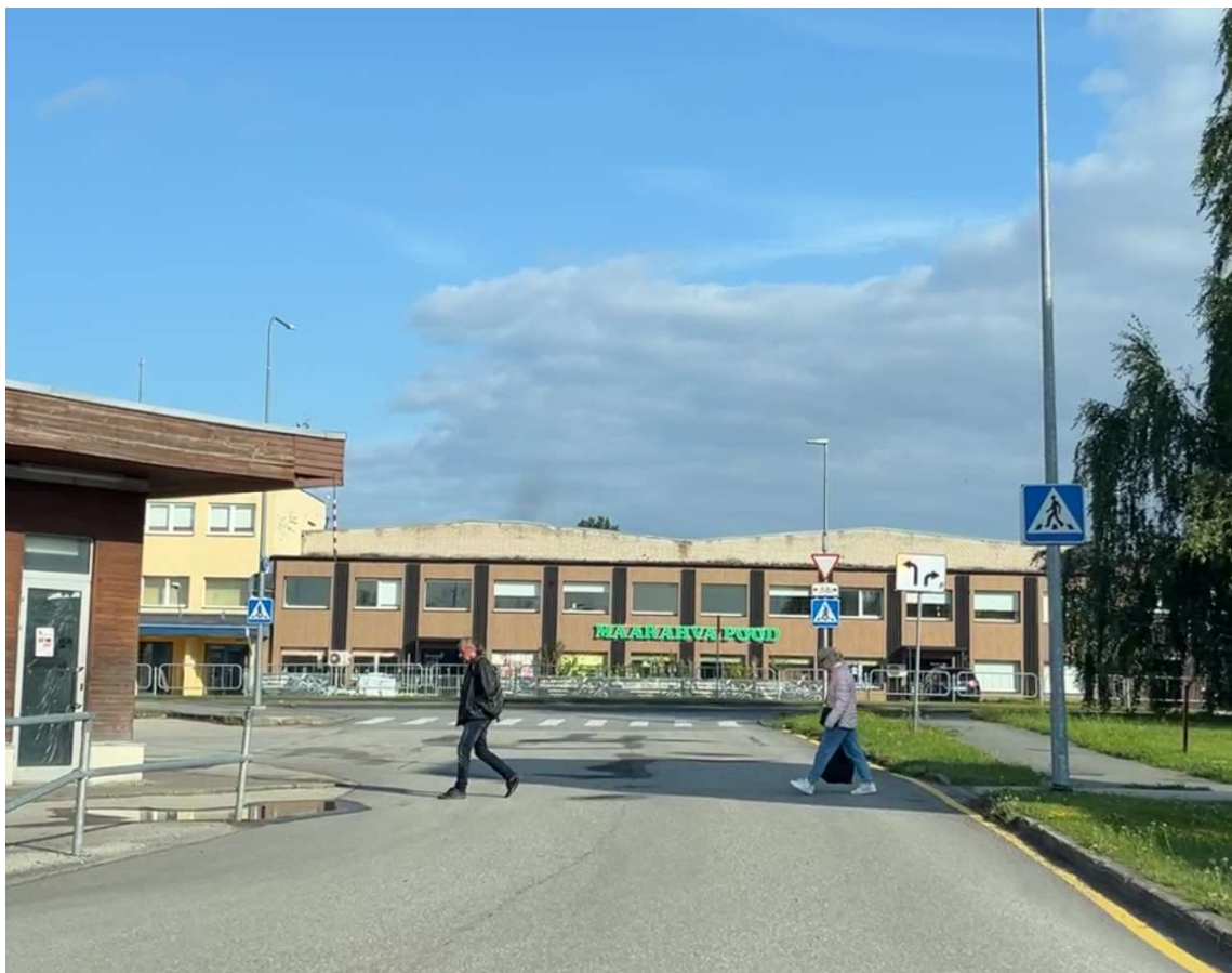
Joonis 17. Puudulikult tähistatud ülekäigurada ning kõnniteede puudumine bussijaama piirkonnas
