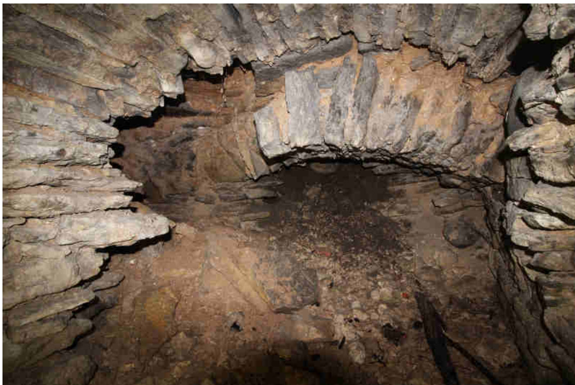
Foto 6. Vaade kinnimüüritud käigule. Käigu võlvi sillusest on kivid osaliselt välja kukkunud (Foto T.Villems)
