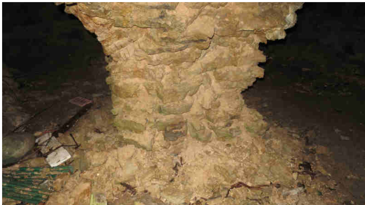
Foto 4. Keskne murenev piilar, lähivaade (Foto T.Villems)
