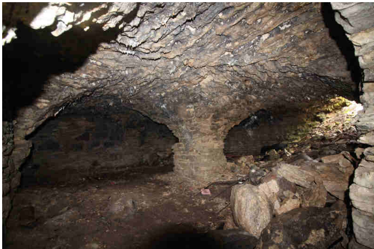
Foto 4. Keskne murenev piilar, lähivaade (Foto T.Villems)
